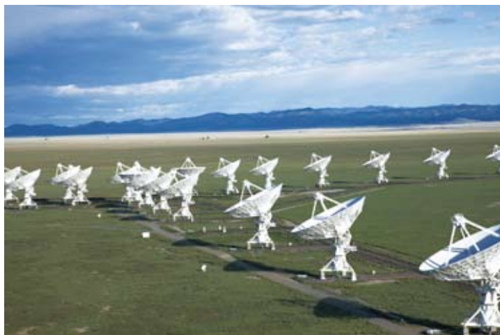
● 限於工程技術，單一天線的電波望遠鏡口徑幾乎無法再增加，為了增加解析度和靈敏度，採取干涉技術的電波望遠鏡陣列成了現今主流的電波觀測儀器。(圖片來源：NRAO / AUI)
