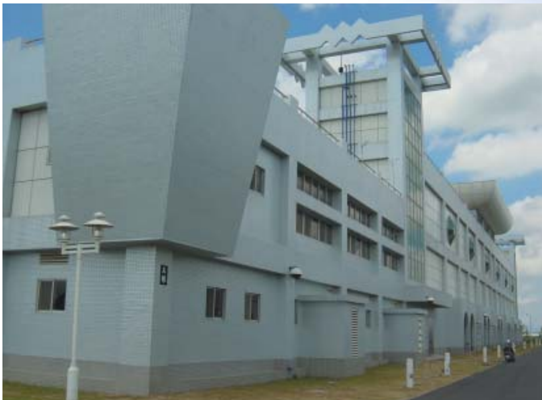
南科超高壓變電所
